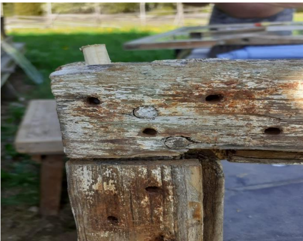
8. Kulman korjaus puutapeilla
