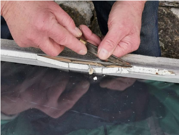
1. Kivettyneen kitin poistoa
