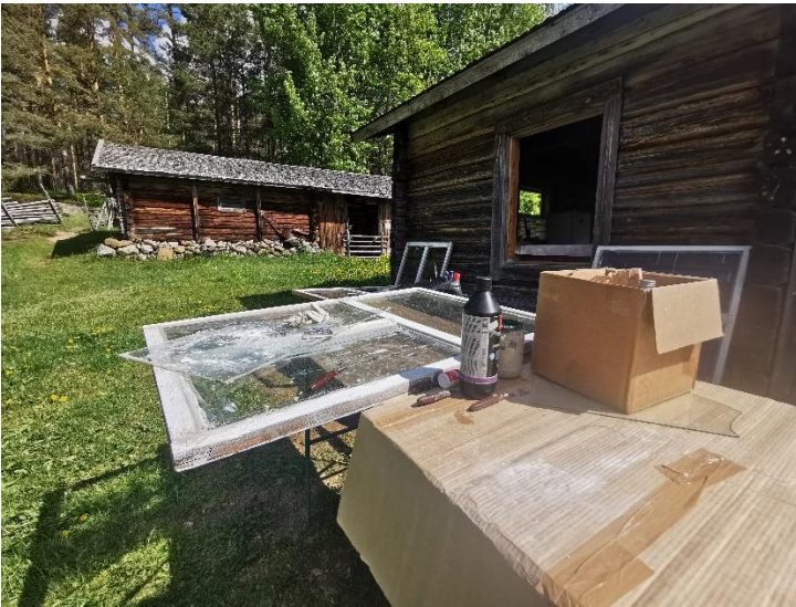
5 . Lasin kiinnityskittaus vaiheessa
