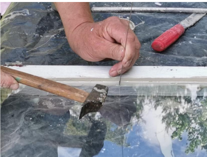
6. Lasin kiinnitystä lasitusnauloilla
